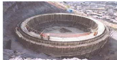
Construcción del reservorio Zona Sur Este
