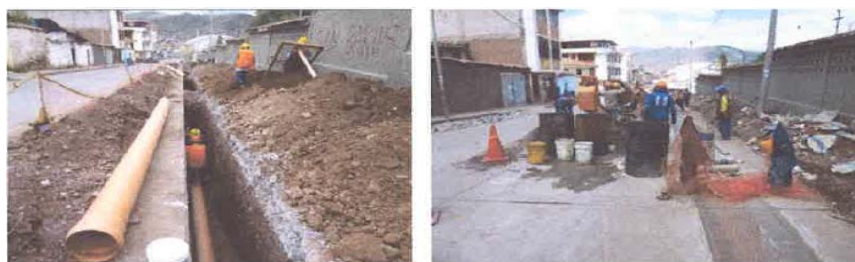
Instalación de tuberías y reposición de pista en calle Retiro – Wanchaq.
