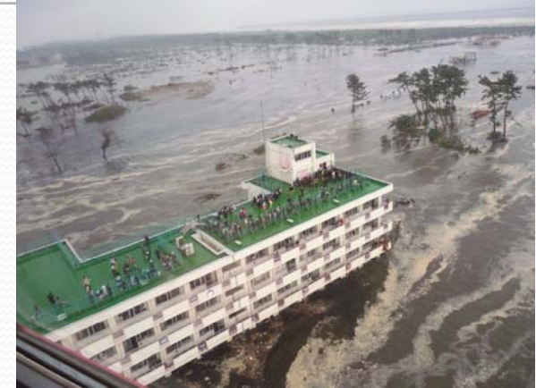
Colegio de primaria Arahama
