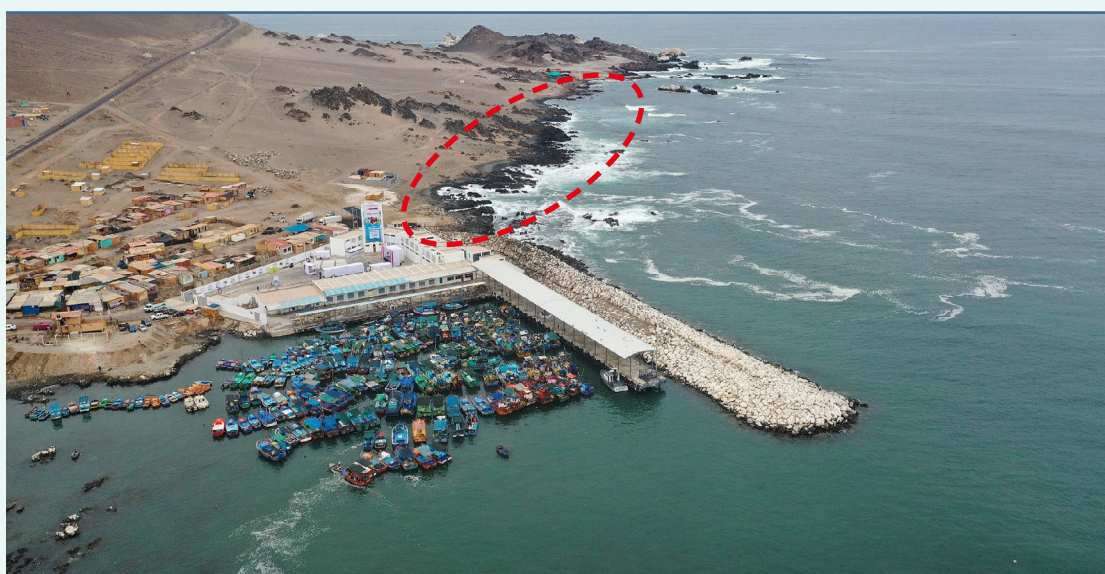
DPA Morro Sama, protegido mediante un rompeola (obra de abrigo artificial)
