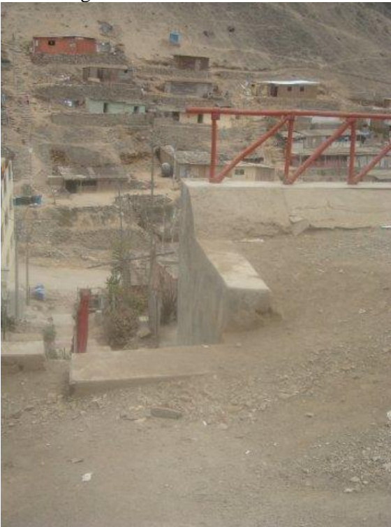
Acceso a gradas
