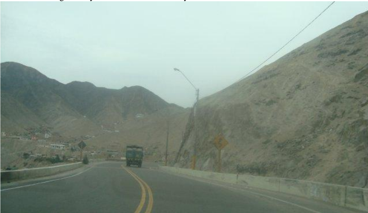
Sardineles de seguridad y señalización horizontal y vertical
