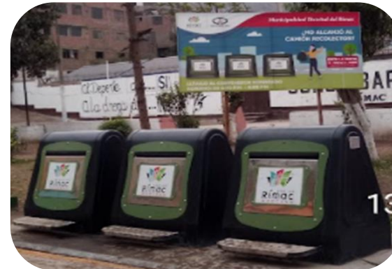
Instalación de tachos y/o contenedores
