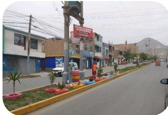
Construcción de sardineles, veredas, asfaltado, etc.
