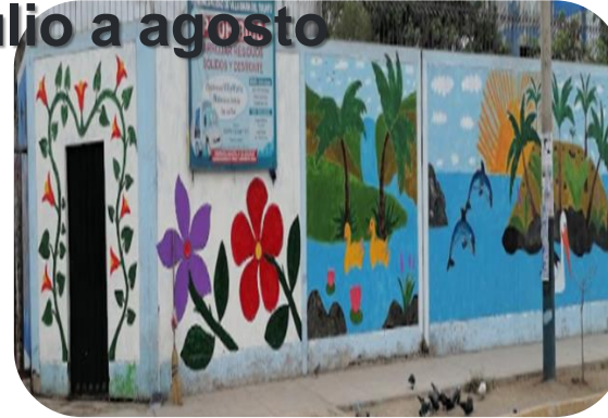
Lavado de postes, lavado y pintado de paredes
