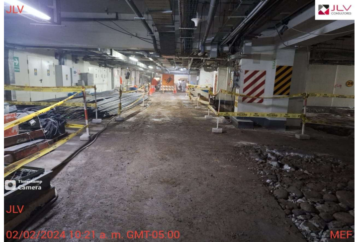
Supervisión verifica que se realice el control de polvo SÓTANO
