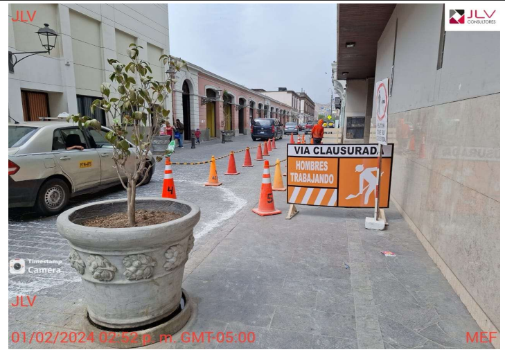
Supervisión verifica que Consorcio Junín realice la señalización exterior de obra
