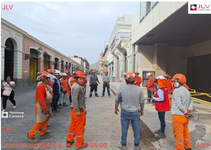
Supervisión verifica la respuesta en caso de sismo de 5.7° del 15/02/2024 3:53pm
