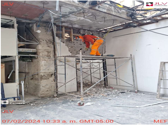
Supervisión verifica el armado correcto de andamios, se le brinda indicaciones al Jefe SSOMA para el correcto armado de andamios
