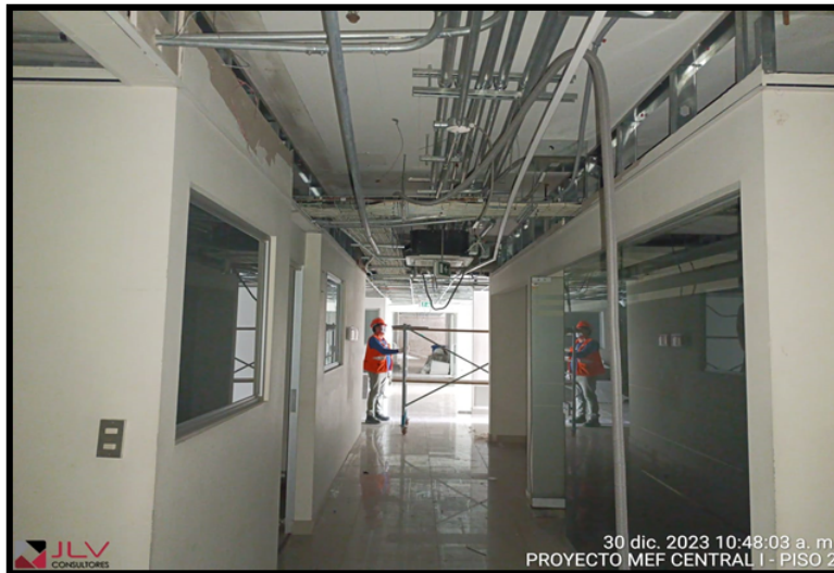
Estado actual de la ejecución de la obra – fotografía al 30 de diciembre del 2023
