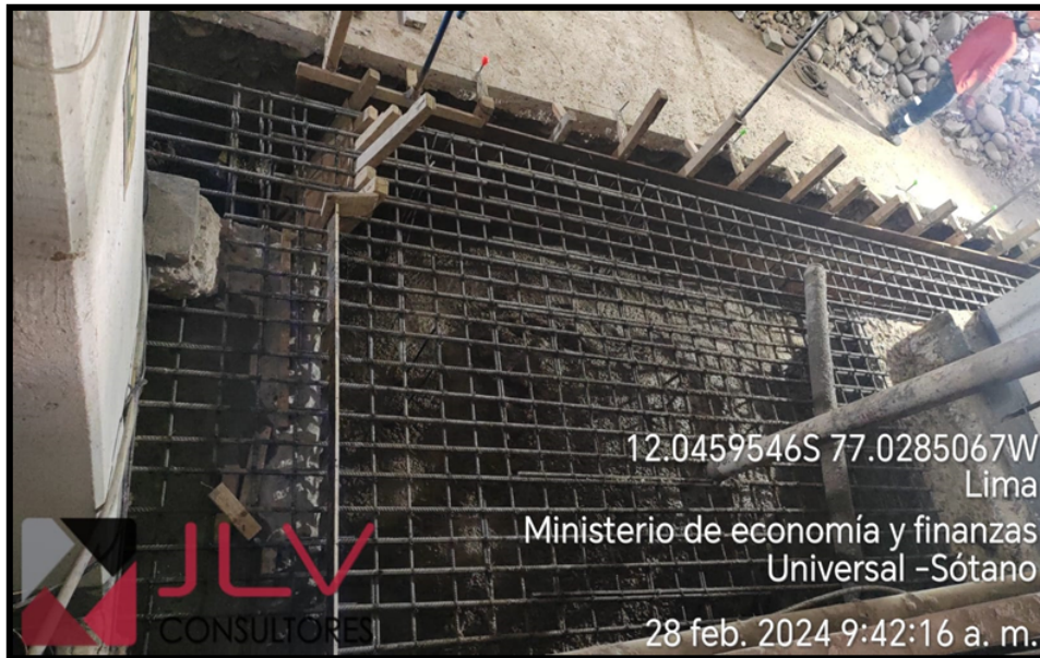
Estado actual de la ejecución de la obra-fotografía al 28 de febrero del 2024
