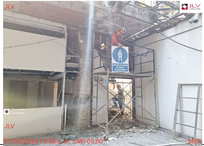
Supervisión verifica el armado correcto de andamios, se le brinda indicaciones al Jefe SSOMA para el correcto armado de andamios
