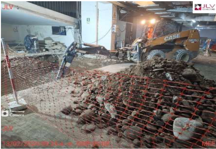
Supervisión verifica los trabajos de minicargador dentro de zona delimitada
