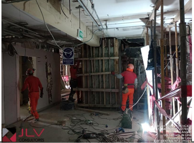
Supervisión verifica el trazo, sección y plomada del encofrado en columnas a reforzarse - Central II Piso 2
