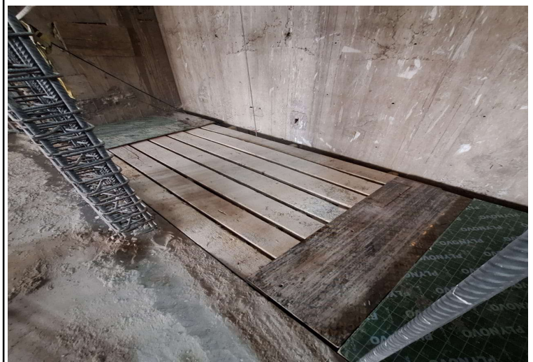
Supervisión verifica el buen estado de la plataforma de trabajo para trabajos en ascensor
