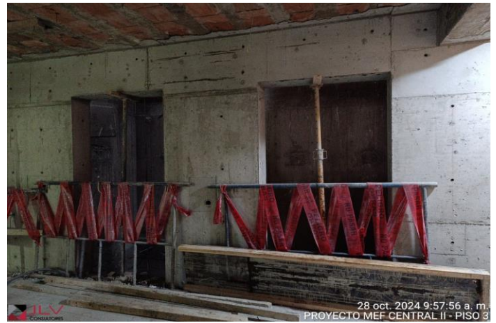
Supervisión examina el acabado de las columna y viga vaciada en el frontis del ascensor sin observaciones - Central II Piso 3
