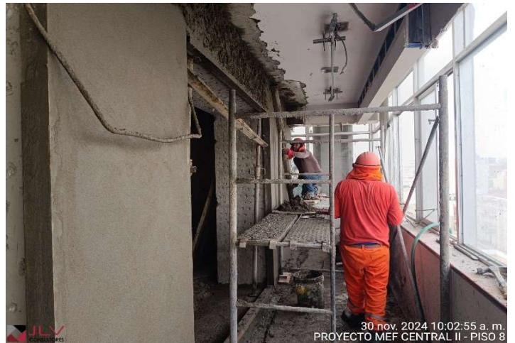
Supervisión evidencia el avance de la partida de tarrajeo en las columnas y vigas de estructuras reforzadas - Central II Piso 8
