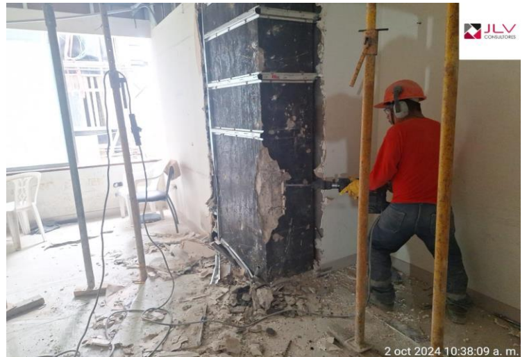
Supervisión verifica el uso de EPP para los trabajos de escarificado
