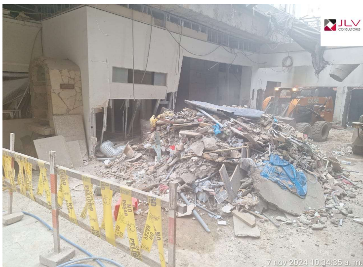
Se verifica el acarreo de desmonte de zonas de difícil acceso hasta punto de acopio
