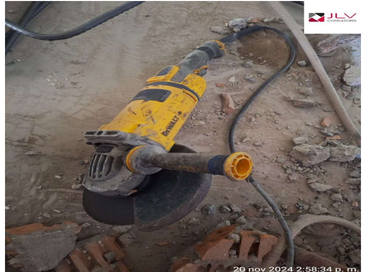
Supervisión verifica la inspección de amoladoras, con guarda y manubrio
