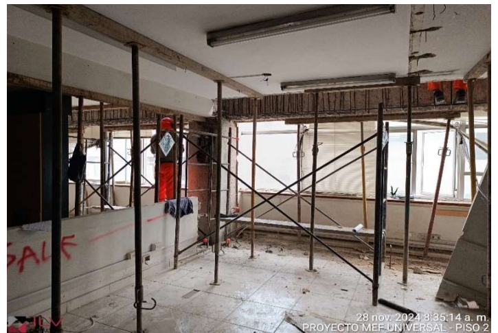
Supervisión observa el encofrado de la viga VRF2 del eje D.U - Universal Piso 2
