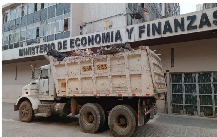
Se realiza 01 viaje de eliminación de desmorte 29/10/2024
