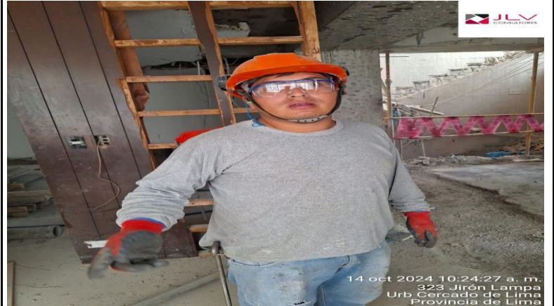
Supervisión verifica el uso correcto de epp
