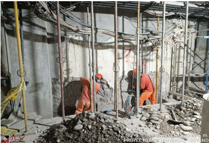
Supervisión observa el avance de la partida de escarificado en la placa PLN-1 - Universal Sótano I
