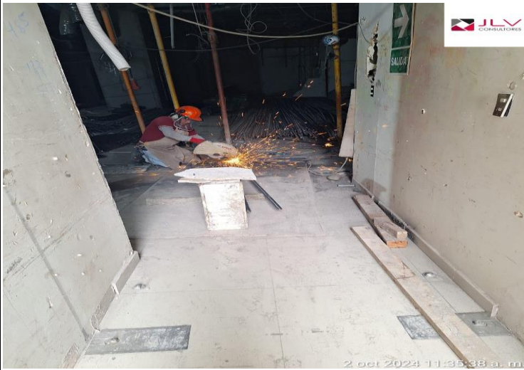
Supervisión verifica el uso de epp para los trabajos en caliente
