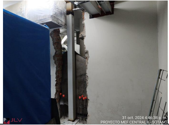
Supervisión observa la instalación de la columna metálica, para el reforzamiento de las vigas del eje A.C2 - Central II Sótano 1
