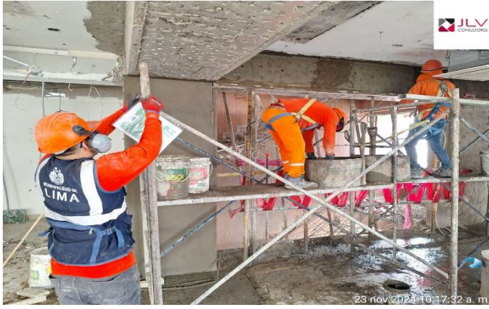
Supervisión verifica la inspección de andamios y colocación de tarjetas de inspección
