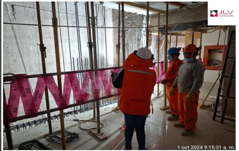
Supervisión realiza el recorrido de inspección para las recomendaciones de seguridad para trabajos en ascensor
