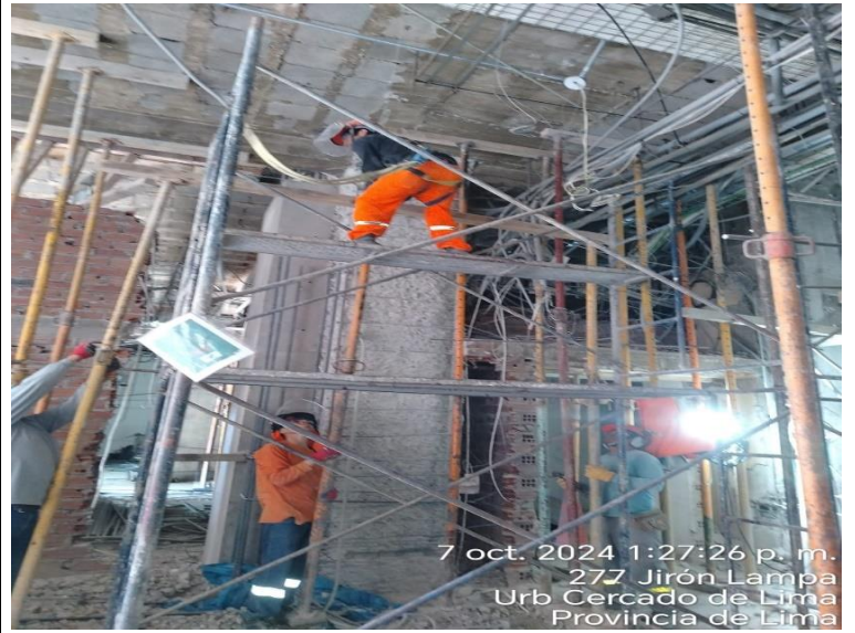
Supervisión verifica la inspección de andamios
