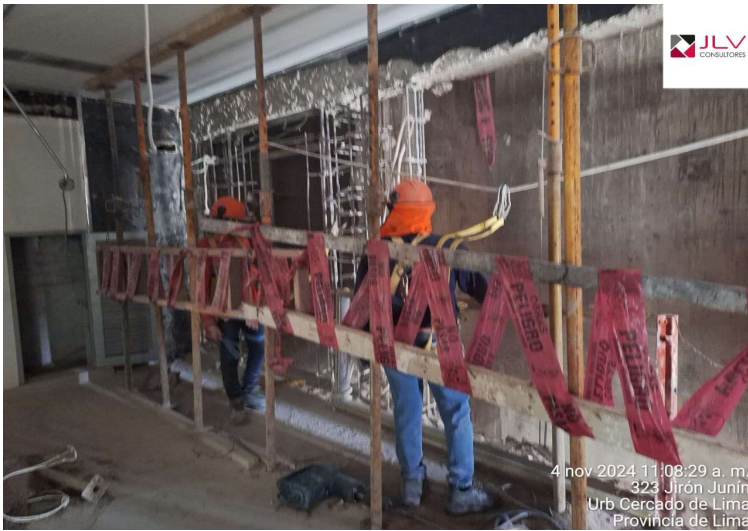
Supervisión verifica el uso de Arneses de seguridad para la realización de trabajos en altura
