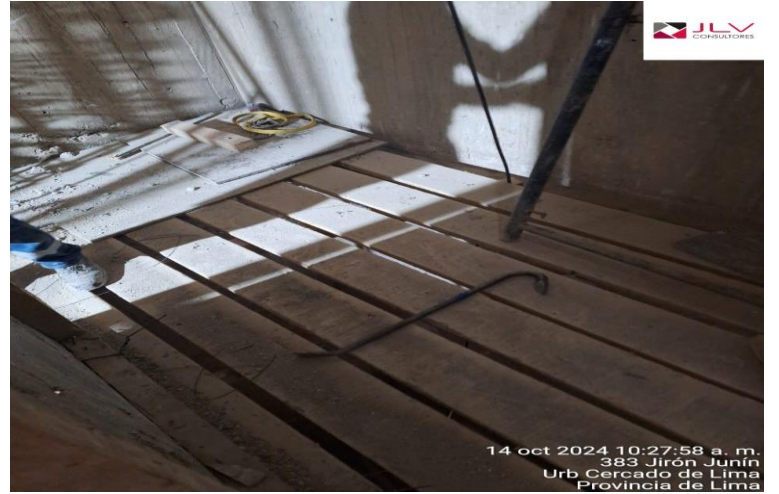
Se realiza el seguimiento a la instalación de plataformas de trabajo en la caja de ascensor
