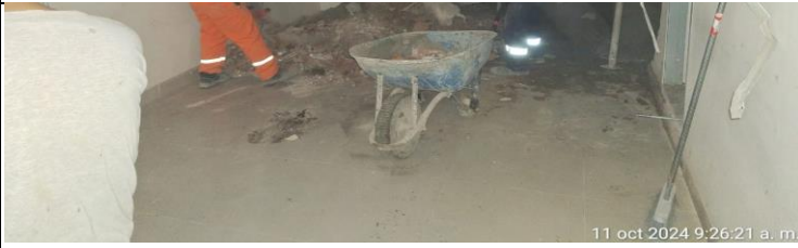
Se verifica la realización de orden y limpieza de las zonas de trabajo
