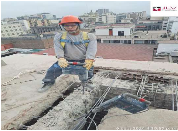
Supervisión verifica el uso de arneses de seguridad para los trabajos en altura y el EPP para trabajos de demolición
