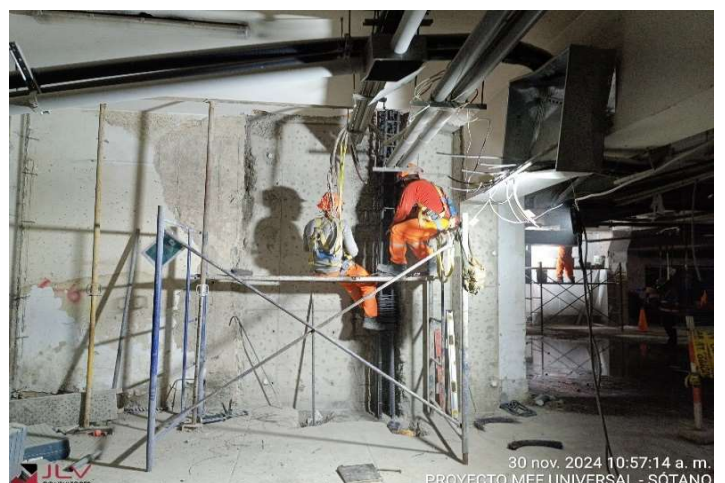
Supervisión constata el avance de la partida de acero de refuerzo en la placa PL-1 - Universal Sótano I
