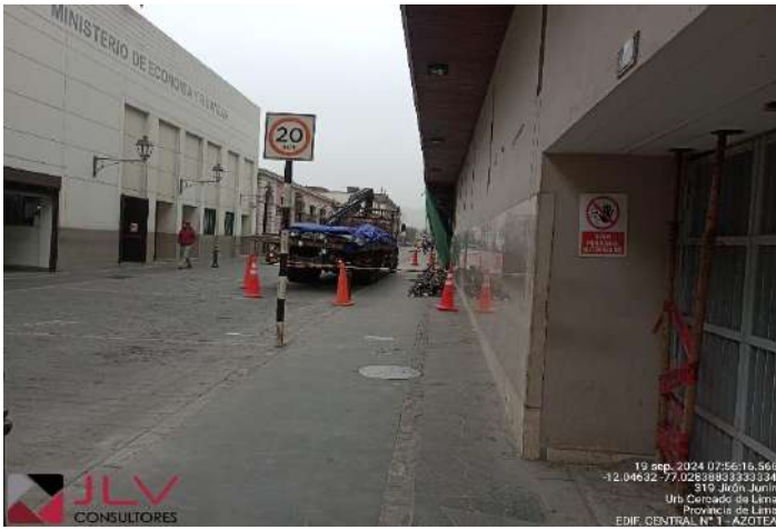
Llegada de materiales a obra (barras de acero) - Exterior de obra.
