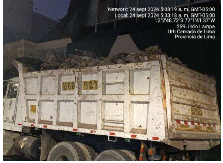
Se verifica la eliminación de 01 viaje de desmote 24/09/2024
