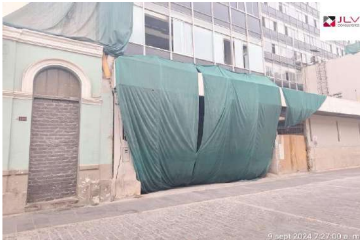
Supervisión verifica la protección con malla raschell en Jr. Lampa
