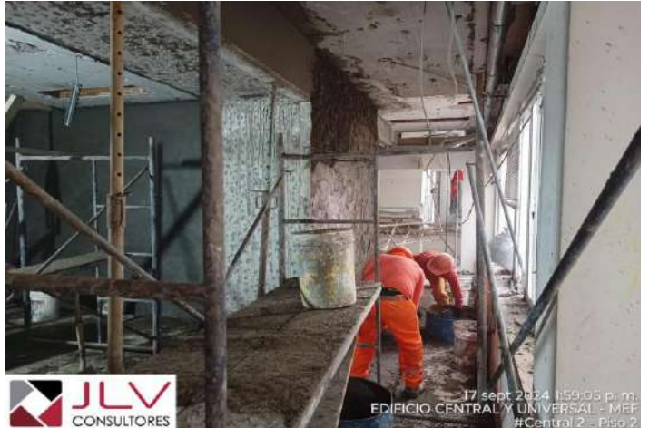
Supervisión verifica el tarrajeo de vigas y placas - piso 2 central 2.
