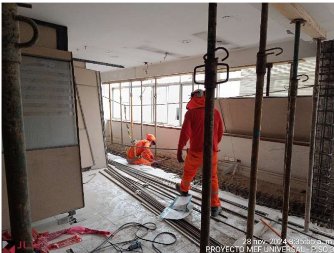
Supervisión observa la colocación de los aceros de refuerzo en la viga VRF2 eje D.U - Universal Techo del Piso 2
