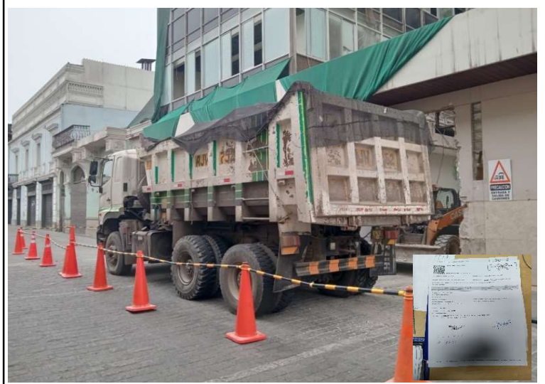
Se verifica la realización de Eliminación de desmonte 28/11/2024
