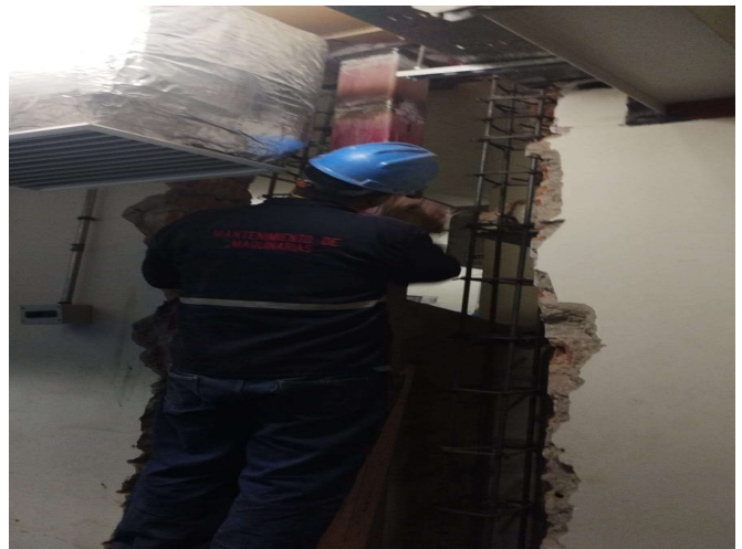
Supervisión verifica el pintado y espesor de pintura de la columna metálica - Central II Sótano I
