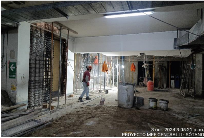
Supervisión observa la colocación de los refuerzos de acero, en las columnas a reforzarse - Central II Sótano 1
