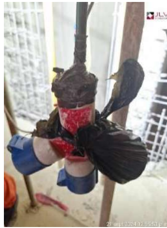
Supervisión verifica y advierte sobre el mal estado de tomas eléctricas
