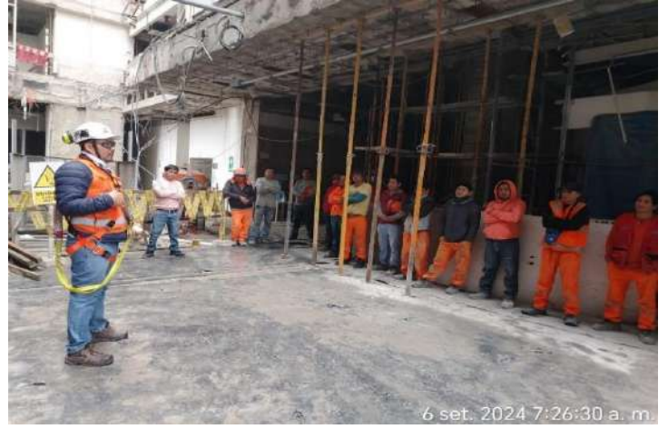
Supervisión realiza la charla de medidas de seguridad para Trabajos en Altura
