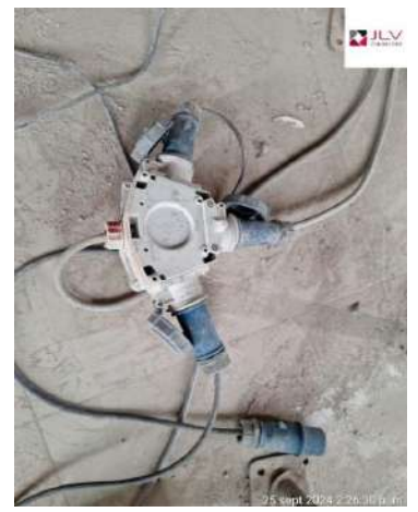
Supervisión verifica y advierte sobre el mal estado de tomas eléctricas
