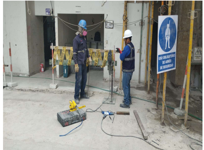
Supervisión evidencia la ubicación y la perforación, para la colocación de la base de las planchas metálicas - Central I Piso 1
