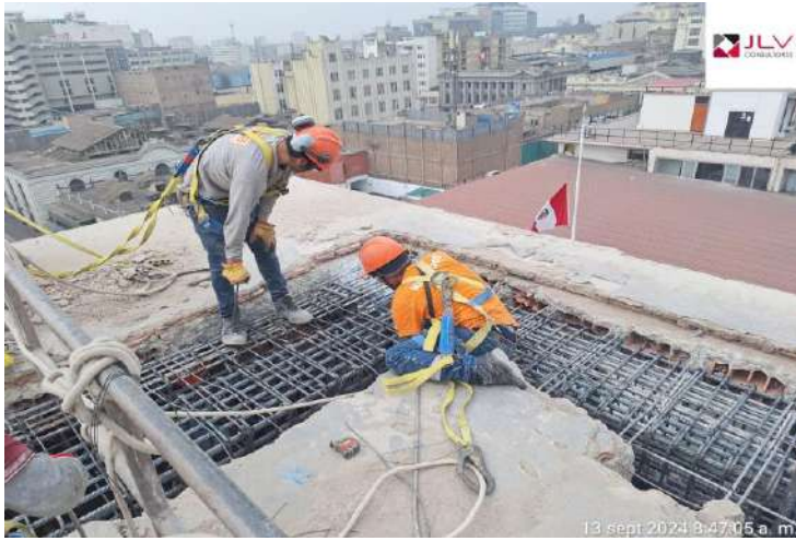
Supervisión verifica el uso de arneses de seguridad para los trabajos en altura
