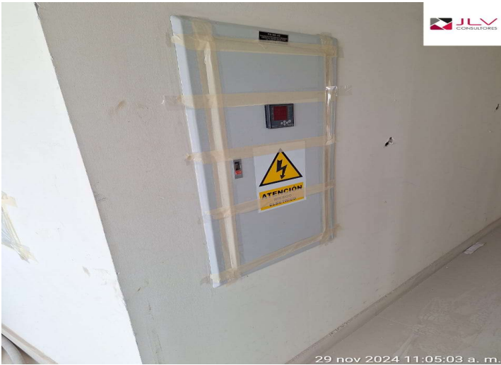
Supervisión realiza el seguimiento al cierre de tableros eléctricos del MEF
