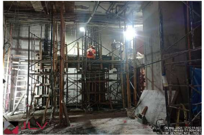
Supervisión verifica el correcto vaciado y vibrado de las columnas y vigas del frontis del ascensor - piso 1 central 2.
