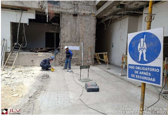
Supervisión evidencia la ubicación, trazo y replanteo, para la colocación de las planchas metálicas - Central I Piso 1
