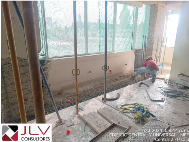
Supervisión observa la colocación de los refuerzos de acero, en las vigas a reforzarse - Central II Techo del Piso 2
