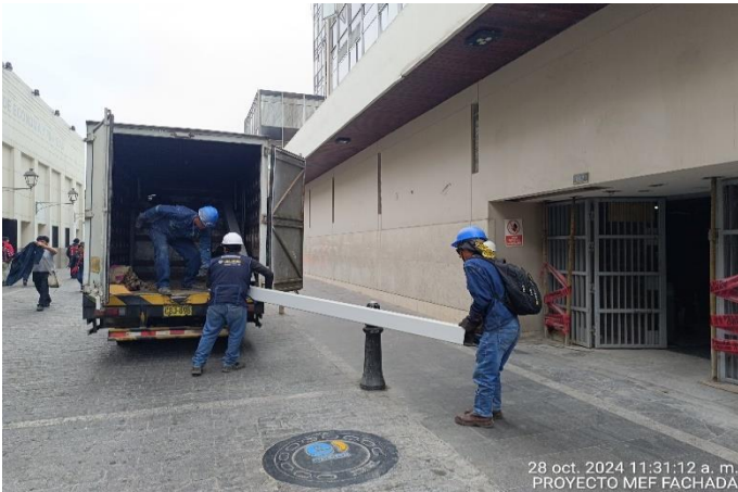
Supervisión evidencia la llegada y descarga de las columnas metálicas, para el reforzamiento de las vigas del eje A.C2 - Central II Sótano 1
