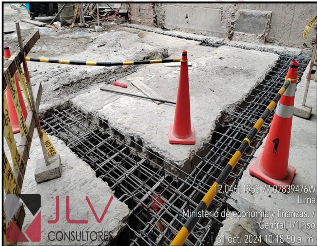
Estado actual de la ejecución de la obra – fotografía al 31 de octubre del 2024
