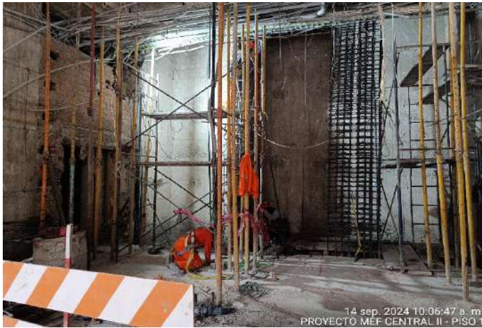
Supervisión corrobora la colocación de los refuerzos de acero en el frontis del ascensor - piso 1 central 2.
