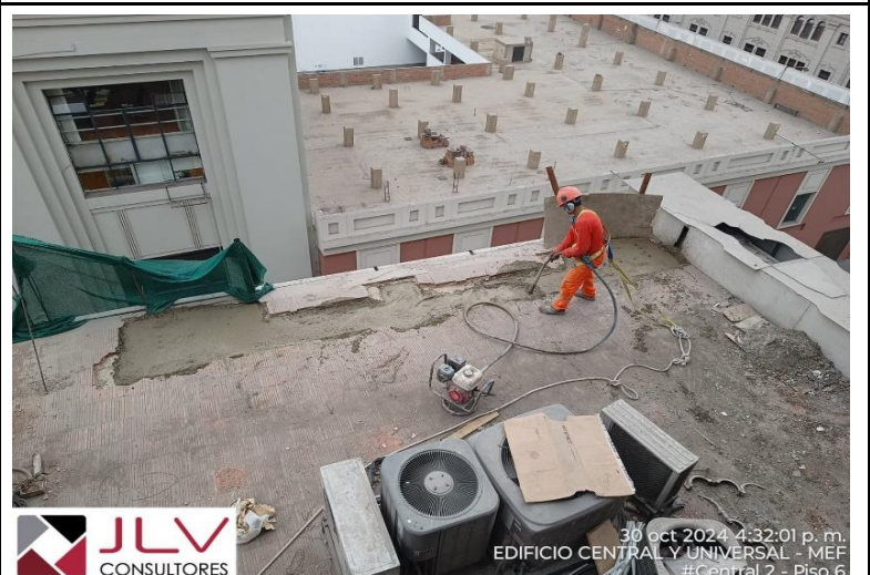
Supervisión verifica el uso de Arneses de seguridad para la realización de trabajos en altura
