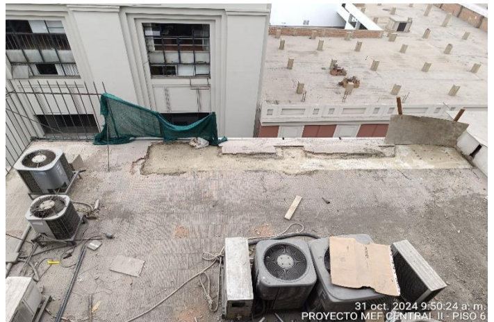
Supervisión constata el correcto nivel de vaciado y acabado de la viga a reforzarse - Central II Techo del Piso 4
