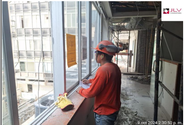
Supervisión verifica el llenado de ATS para la realización de trabajos
