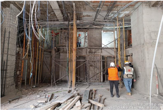
Supervisión verifica el desencofrado de columna y viga vaciada en el frontis del ascensor - Central II Piso 1
