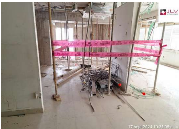
Supervisión verifica la realización de orden y limpieza de las zonas de trabajo
