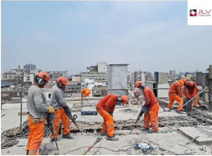
Supervisión verifica el uso de EPP para los trabajos de picado y escarificado
