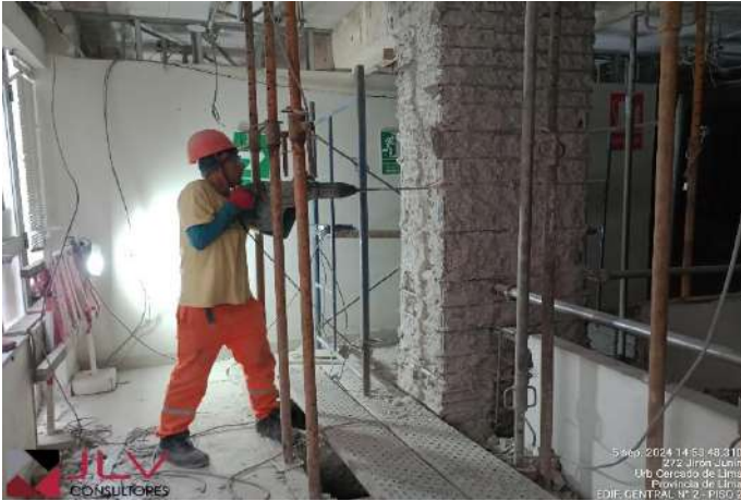
Supervisión observa el avance de la partida de perforación de columnas - piso 2 central 2.
