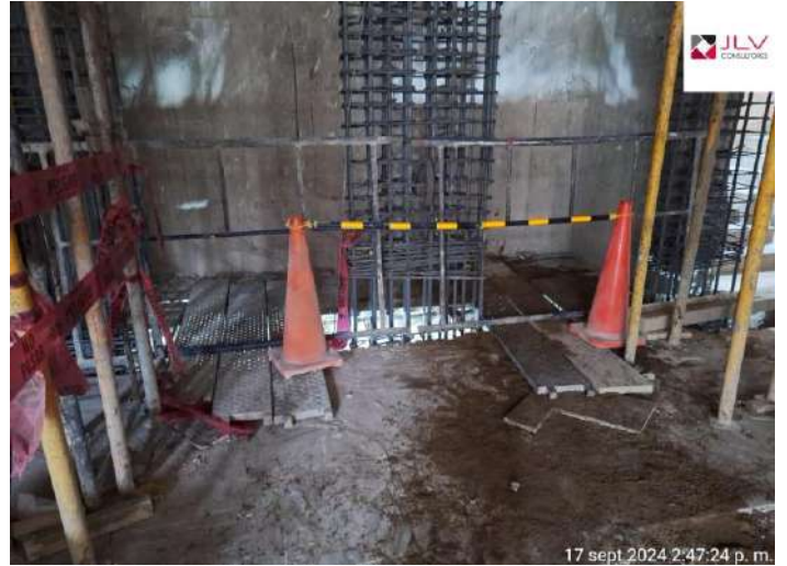
Se realiza la señalización y bloqueo de la zona de trabajo
