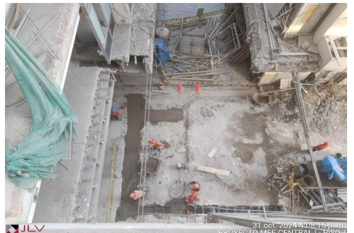
Supervisión verifica el correcto vaciado, vibrado y acabado de las vigas a reforzarse - Central I Piso 1
