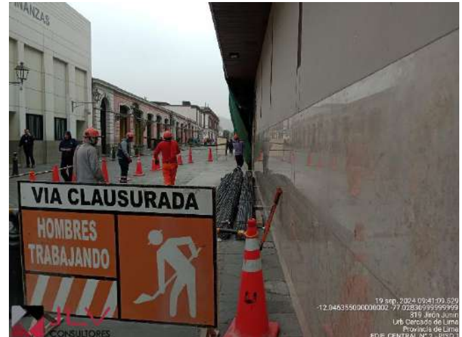
Supervisión evidencia el acarreo de las barras de refuerzo de acero - Exterior de obra.
