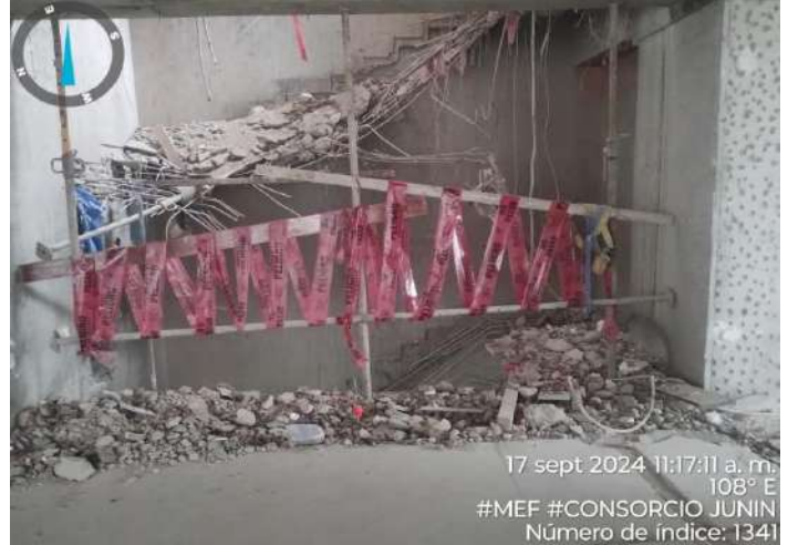
Supervisión verifica la señalización de zonas de riesgo
