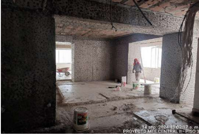
Supervisión evidencia la colocación de puntos en muros escarificado, previo al tarrajeo - piso 3 central 2.
