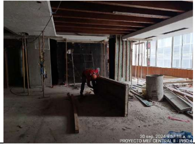
Supervisión observa el avance de la partida de encofrado en la columnas CR1" eje B - piso 4 central 2.
