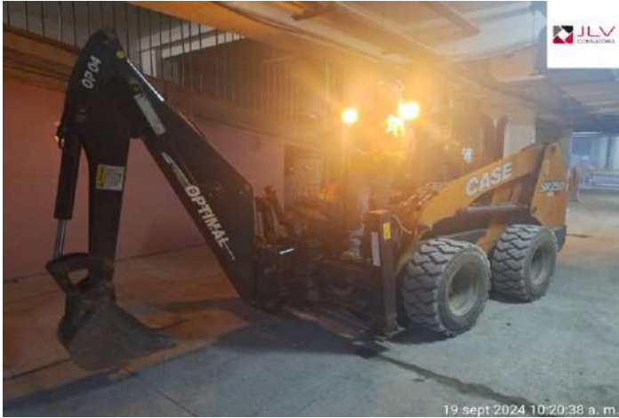
Supervisión verifica el funcionamiento de las luces , llenado de ATS y check list del minicargador
