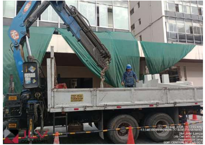
Supervisión verifica la señalización exterior para descarga de ménsulas y brazos
