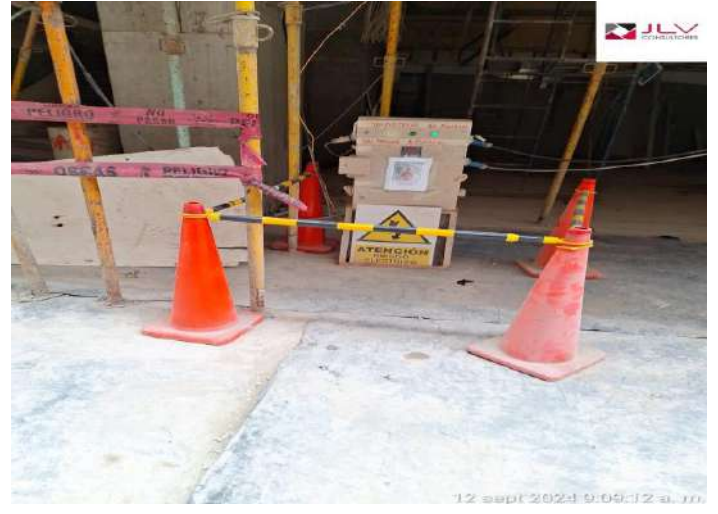
Supervisión verifica la señalización de tableros eléctricos
