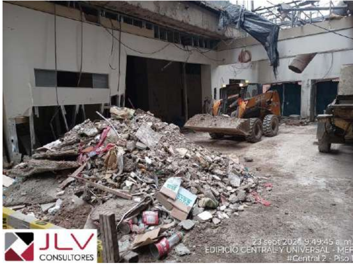
Supervisión verifica el acarreo de desmote con apoyo de minicargador
