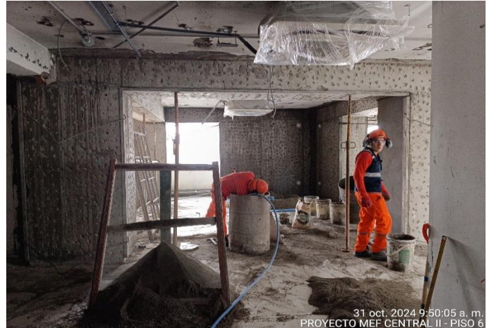
Supervisión evidencia el avance de la partida de tarrajeo en las columnas y vigas reforzadas - Central II Piso 6
