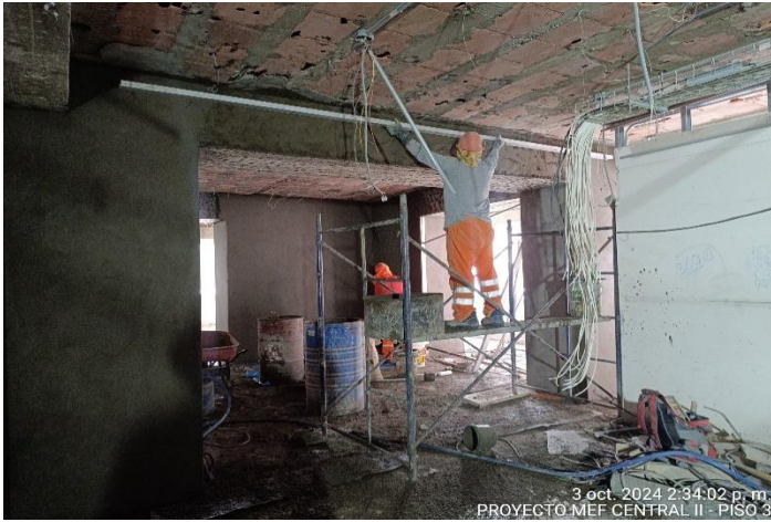
Supervisión evidencia el avance de la partida de tarrajeo en las columnas y vigas reforzadas - Central II Piso 3
