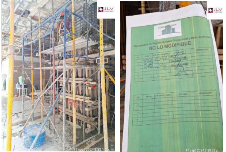
Supervisión verifica la colocación y actualización de la tarjeta de andamios
