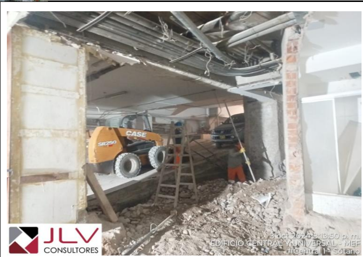
Supervisión verifica el acarreo de desmonte con apoyo de minicargador
