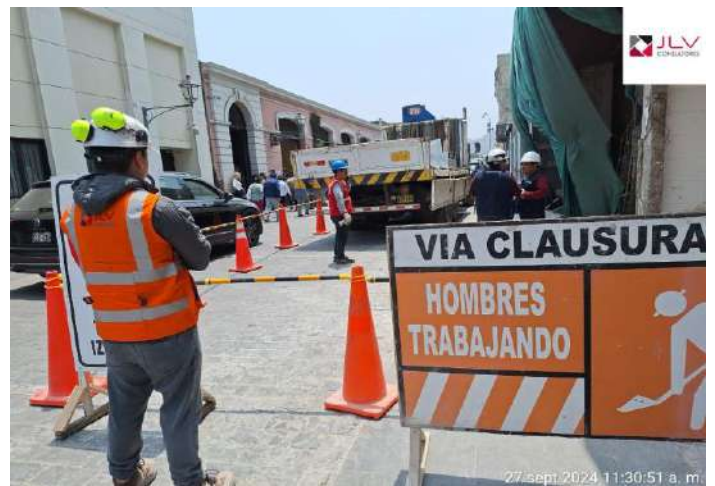
Supervisión verifica las medidas de seguridad para la descarga de Ménsulas
