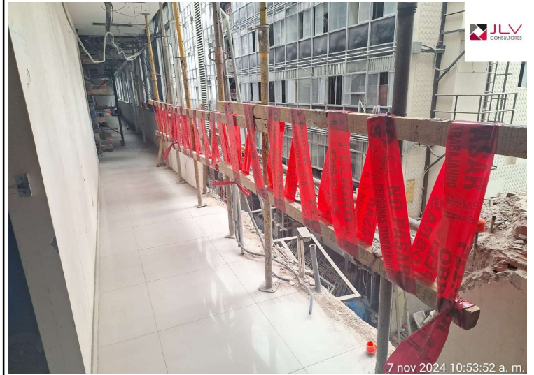
Supervisión verifica el estado de las barandas de obra
